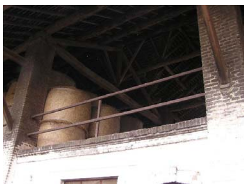
Parapetto di protezione
